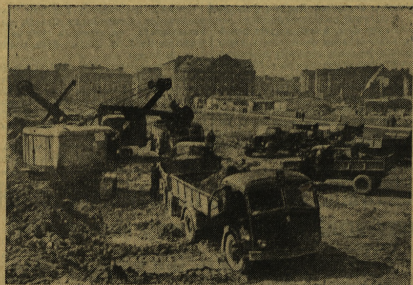
Na zdjęciu fragment wielkich robót ziemnych prowadzonych na 50-hektarowym placu przed budową Pałacu Kultury i Nauki w Warszawie. Foto — Wł. Piotrowski.
