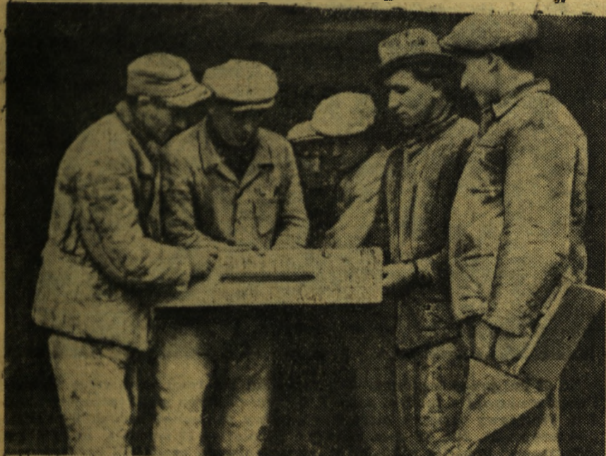
Przez wielką halę jednego z obiektów przemysłowych na Woli przebiega w sobotę około godziny 14 elektryfikacja wiadomości: SKOŃCZYLI! Skończyli w terminie!
