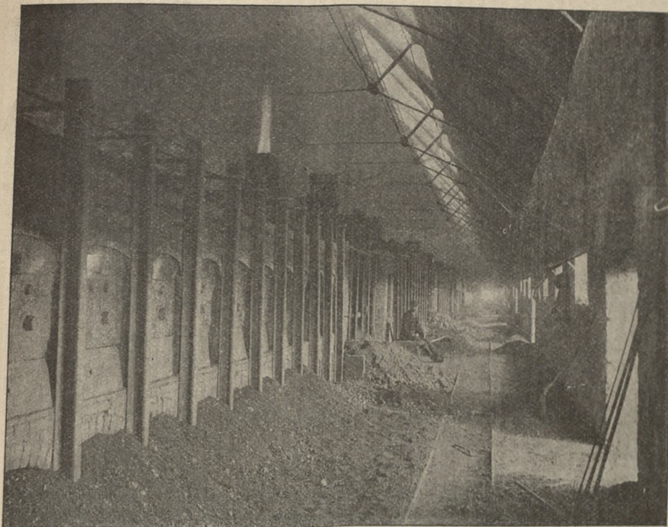
Wnętrze huty cynkowej w Dąbrowie Górniczej.
