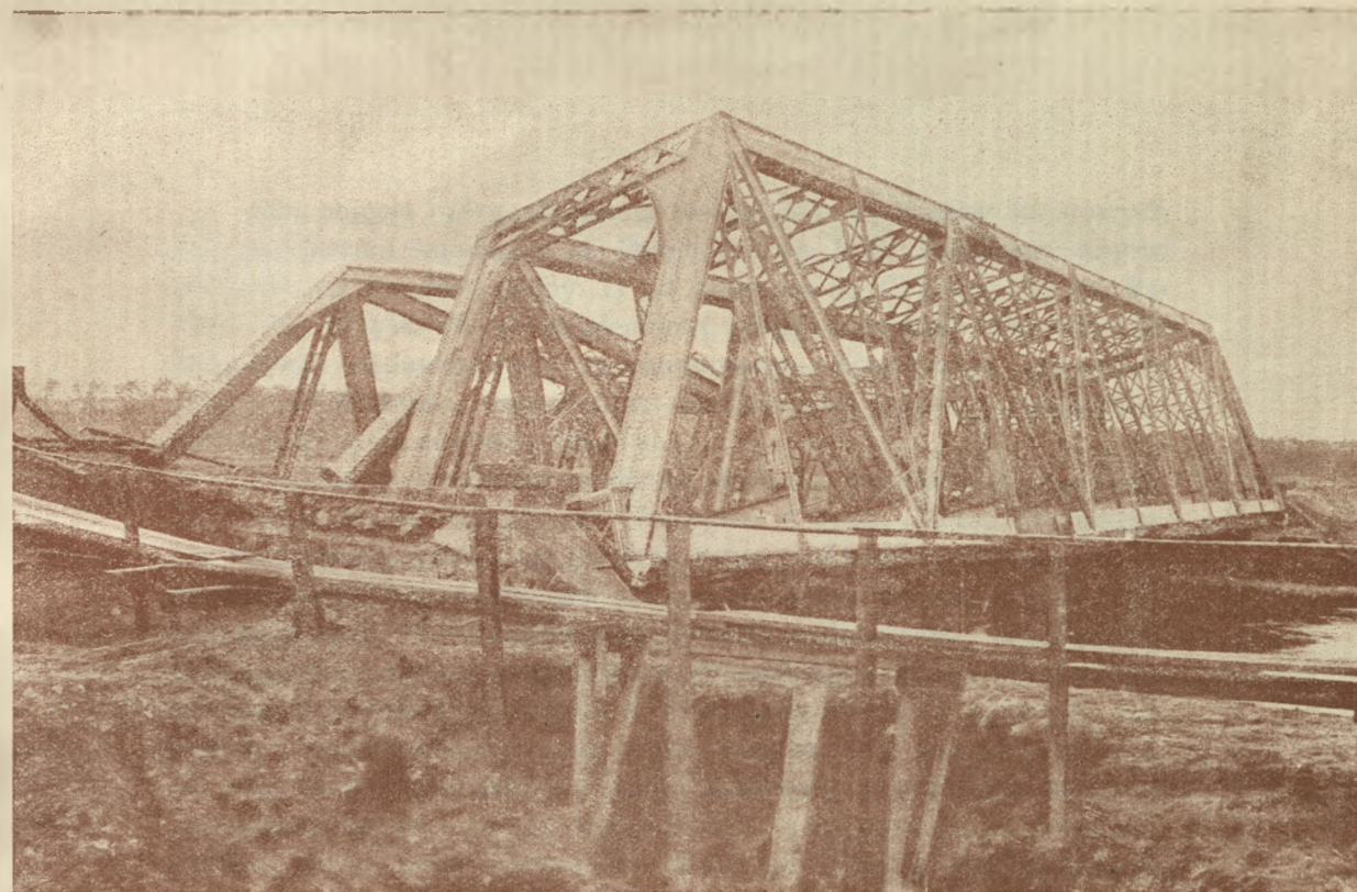
ZRUJNOWANY MOST NA KAMIENNEJ POD SKARŻYSKIEM.
