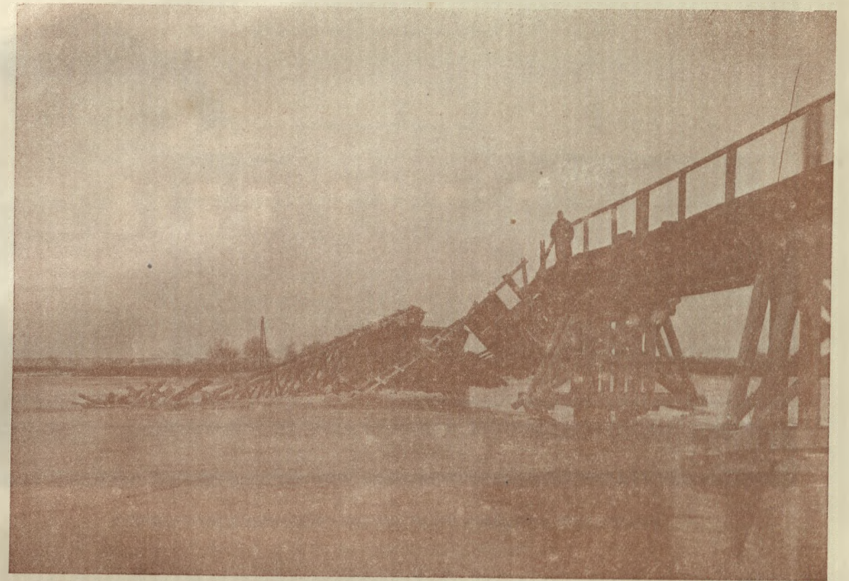
ZNISZCZONY PRZEZ FALE WISŁY PROWIZORYCZNY MOST POD DĘBLINEM.
