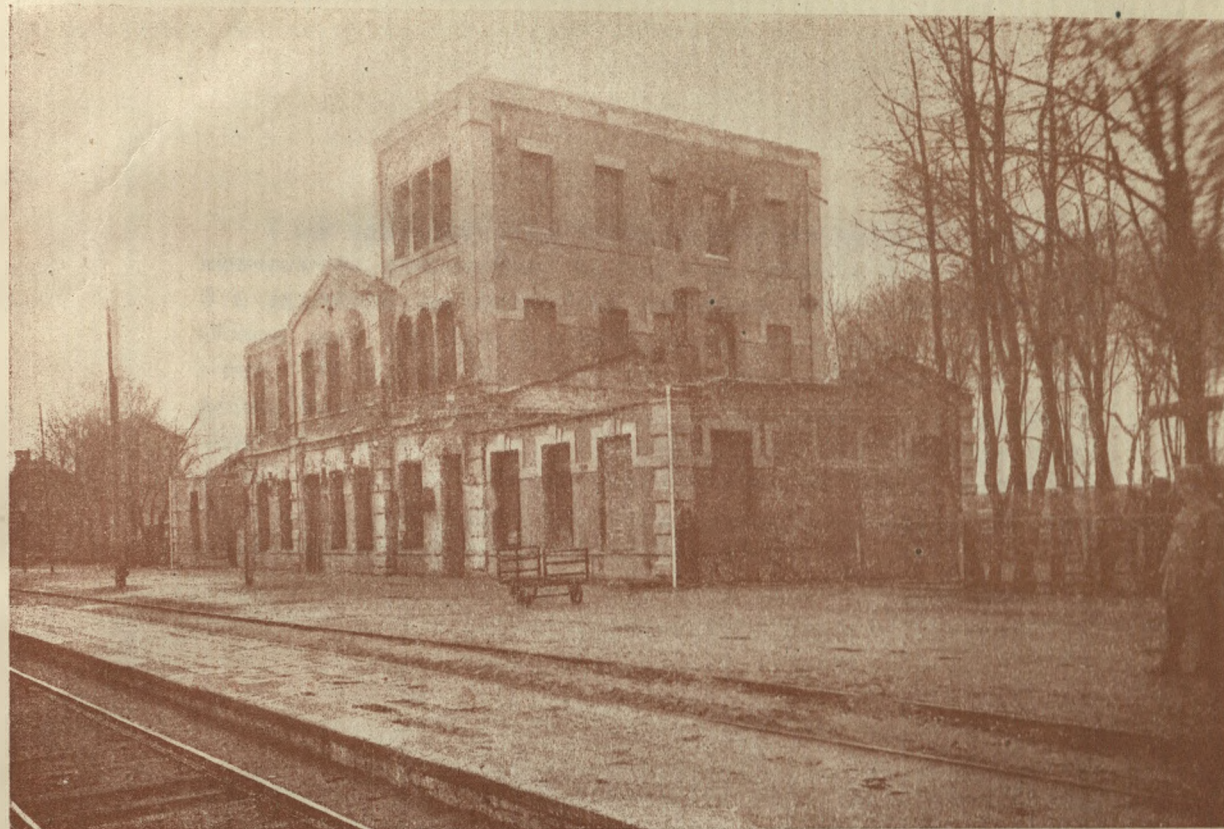
SPALONY DWORZEC STACJI MIECHÓW.
